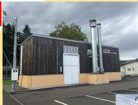
下川町・チップボイラー
